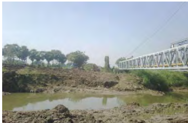
Kondisi pipa yang telah di perbaiki dengan cara metoda Zinker.
