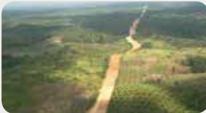
Jalur pipa transmisi Grissik-Pakardewa.
