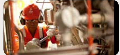
Operasi pemeliharaan dan pengoperasian infrastruktur gas oleh PGAS Solution.
