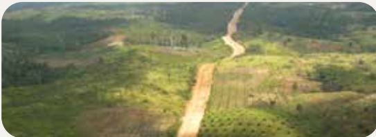
Jalur pipa transmisi Grissik-Pakardewa.
