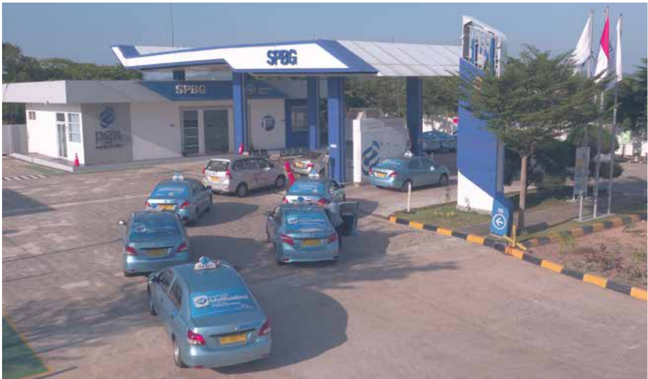
Kehandalan pengoperasian fasilitas SPBG tak terlepas dari dukungan WIDAR dalam menyediakan Gas Engine Generator sebagai sumber energi untuk SPBG.
