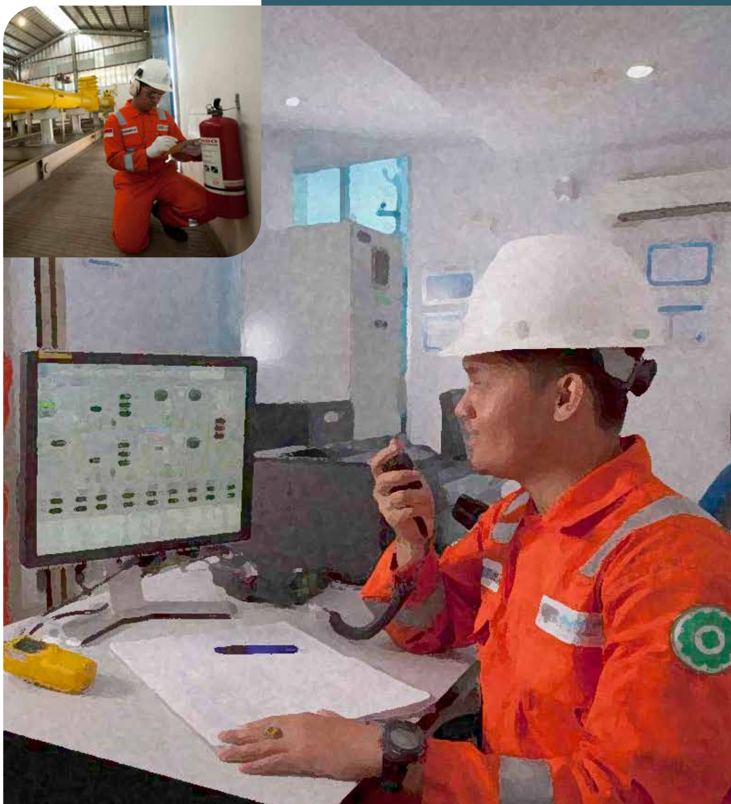
Melalui Supervisory Control and Data Acquisition (SCADA) System PGN mampu mengatur dan mengontrol penyaluran pipa dari jarak jauh.
