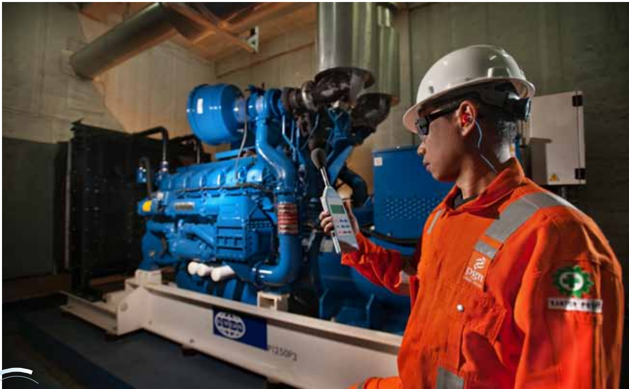
Pengukuran tingkat kebisingan menggunakan sound level meter di lingkungan Kantor Pusat PGN dalam rangka implementasi sistem manajemen K3.
